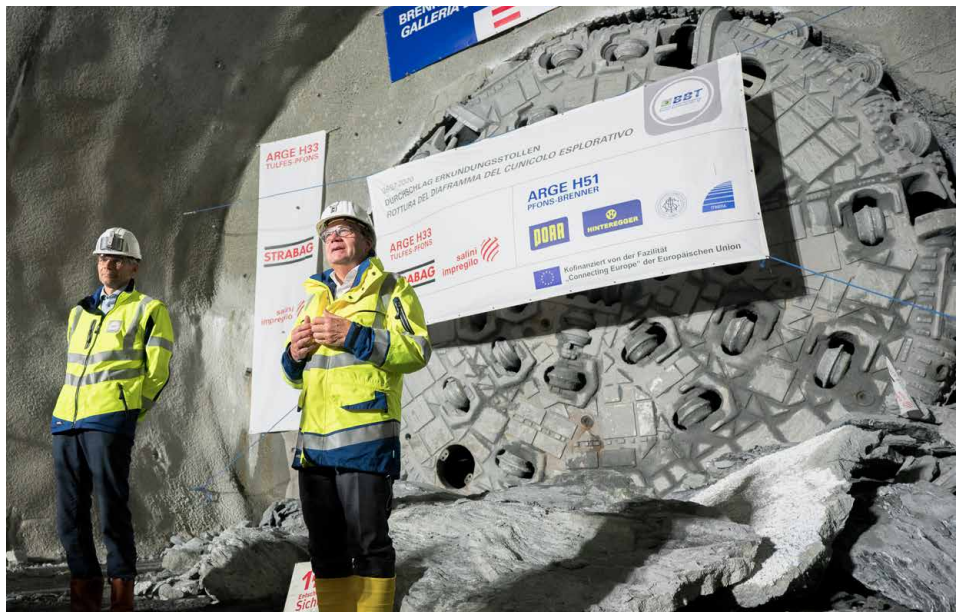
Der Brenner Basistunnel ist das Herzstück der europäischen Nord-Süd-Verkehrsachse.
