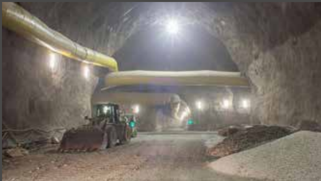
580 Meter unter dem Brennerpass entsteht die längste unterirdische Eisenbahnverbindung der Welt für den Güter- und Personenverkehr. Insgesamt umfasst das Tunnelsystem des BBT ca. 230 Tunnelkilometer. Davon sind 58 km ausgebrochen. Derzeit sind vier Baustellen aktiv, zwei auf österreichischem und zwei auf italienischem Staatsgebiet.
