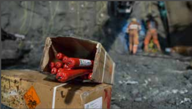
Je fester der Fels, desto mehr Sprengstoff wird benötigt. Zuerst werden Bohrlöcher angefertigt. Diese werden mit Sprengstoff besetzt und Zünder angebracht.
